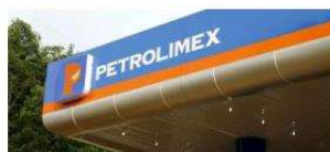
Mái che trạm xăng
